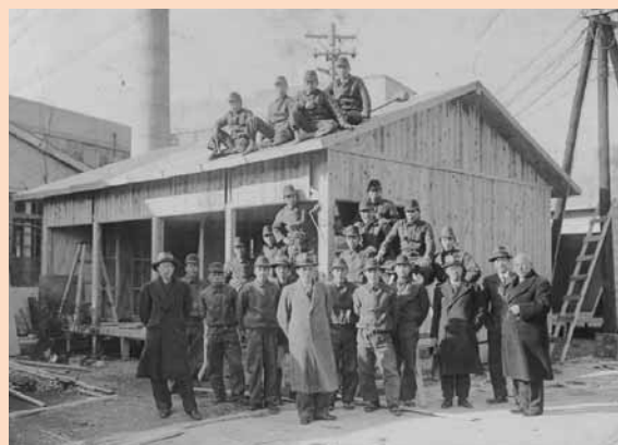
写真3 パネル式木造組立住宅（中央に市浦）1942年
